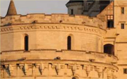
Tejado de la Torre de los Mínimos.
