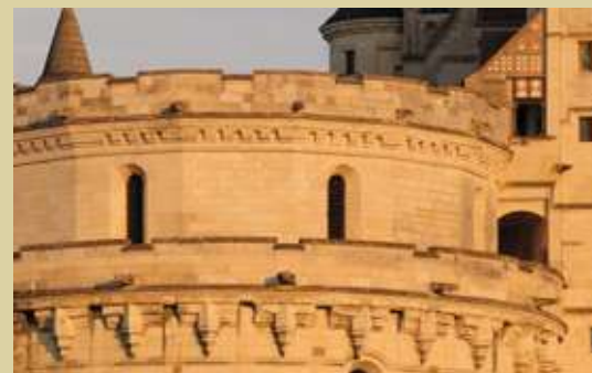
Toit de la Tour des Minimes
